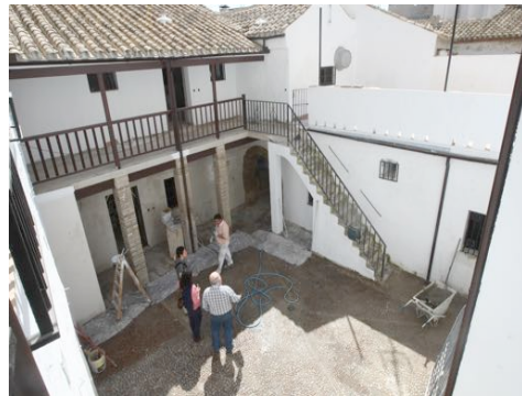
Casa patio de Martín de Roa 7, posterior a la rehabilitación 2011.
