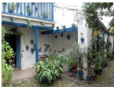
San Juan de Palomares 11, antes de la rehabilitación, edificio desocupado.
