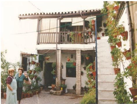
Casa patio de Martín de Roa 7, antes de la rehabilitación 2011.
